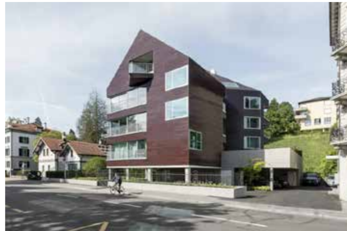
Abb. 47: Wohngebäude in Zürich, Solaris 416, opake PV-Fassade und Dach, einheitliche Farbwahl der verwendeten Module (© Beat Bühler)
