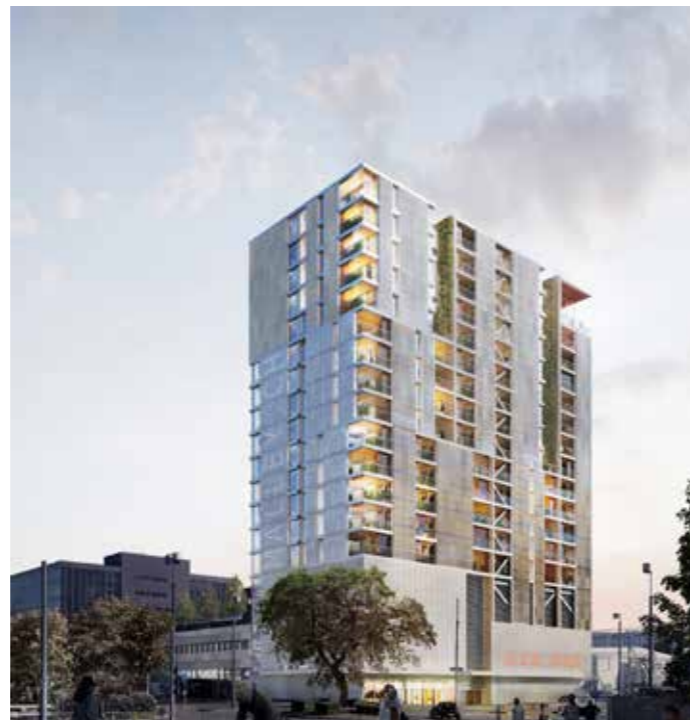
Abb. 53: Auch bei über 30 m hohen Gebäuden können PV-Fassaden angewendet werden. Objektspezifische Lösungen sind in Zusammenarbeit mit Fachexperten zu entwickeln (© Malley Phare CCHE, Prilly/Lausanne)
