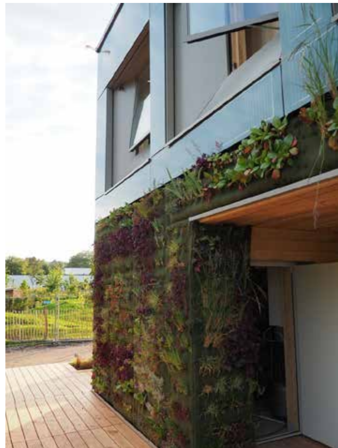
Abb. 112: SolarDecathlon 21/22 Eingabe von Local+. Bei der Fassadengestaltung wurden PV und begrünte Flächen klar von einander getrennt (© team-localplus)
