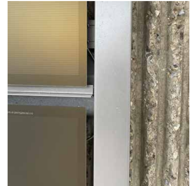
Abb. 67: Fertig installierte Brandabschottung zwischen zwei Modulen (© Silvia Domingo Irigoyen)
