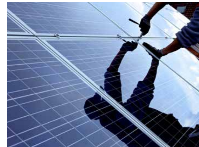
Abb. 50: Eine gute Demontierbarkeit der einzelnen Module erleichtert den Ersatz bei Schäden und Defekten (© AdobeStock)
