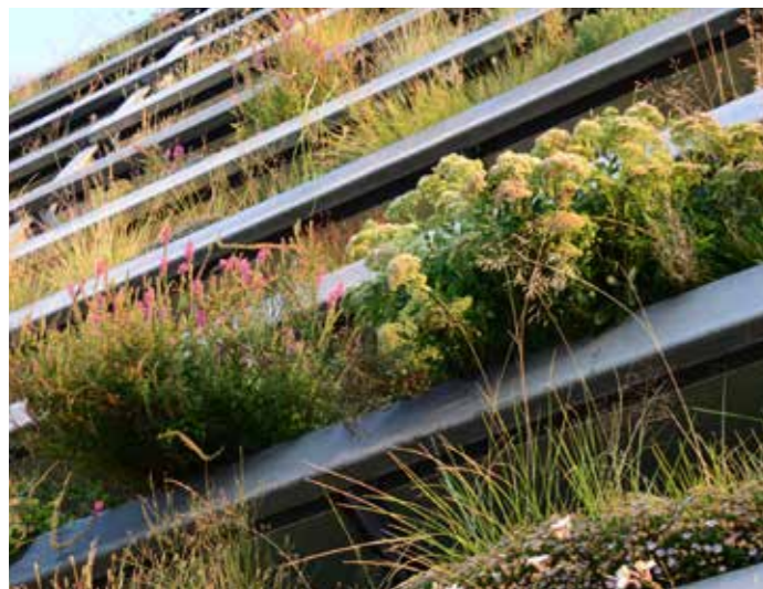
Abb. 36: Zweimal im Jahr ist ein Pflegedurchgang der Fassadenbegrünung notwendig (© Roger Ingold)
