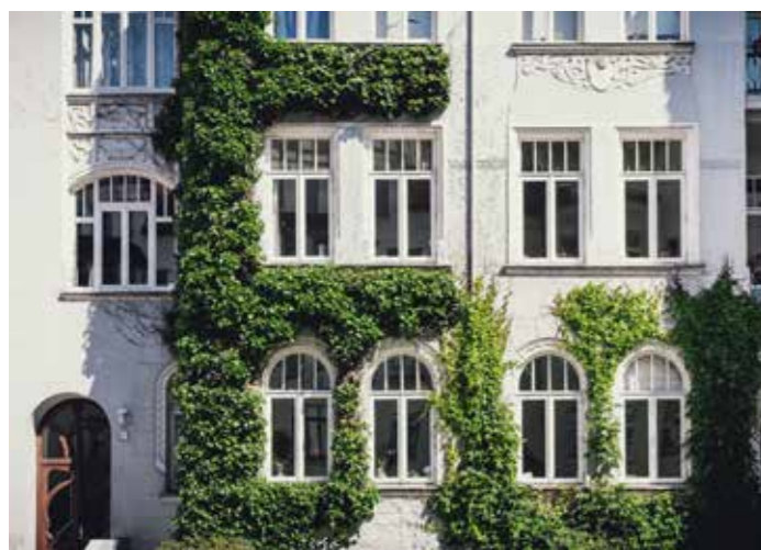
Abb. 21: Bodengebundene Begrünung, ein Überwachsen der Fenster kann durch eine entsprechende Pflege verhindert werden
