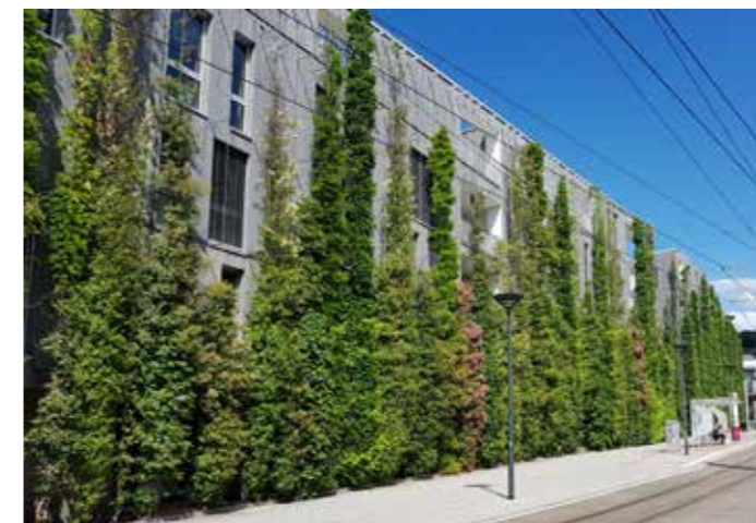
Abb. 26: Insbesondere in Strassenräumen kann der benötigte Platz für die Substratschicht bei bodengebundenen Systemen zum Ausschlusskriterium werden (© Roger Ingold).
