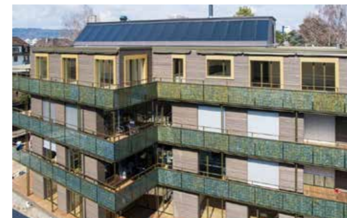
Abb. 4: Mehrfamilienhaus in Altstetten, PV-Module an den Balkonen bieten Privatsphäre und schaffen gleichzeitig eine horizontale Gliederung der Fassade (© Kämpfen Zinke + Partner AG)
