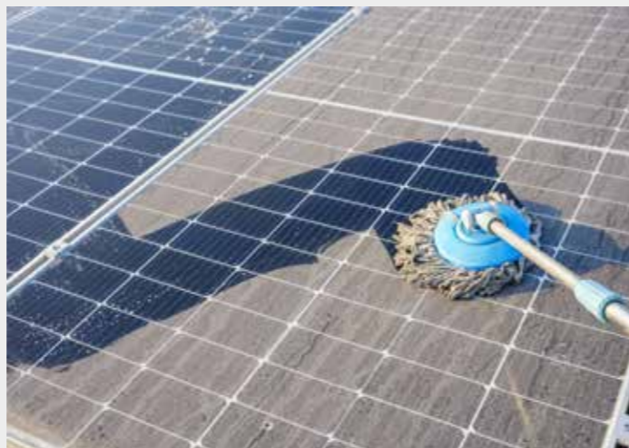
Abb. 44: Verschmutzungen können den Stromertrag mindern, eine regelmäßige Reinigung ist empfehlenswert (© Adobe-Stock)
