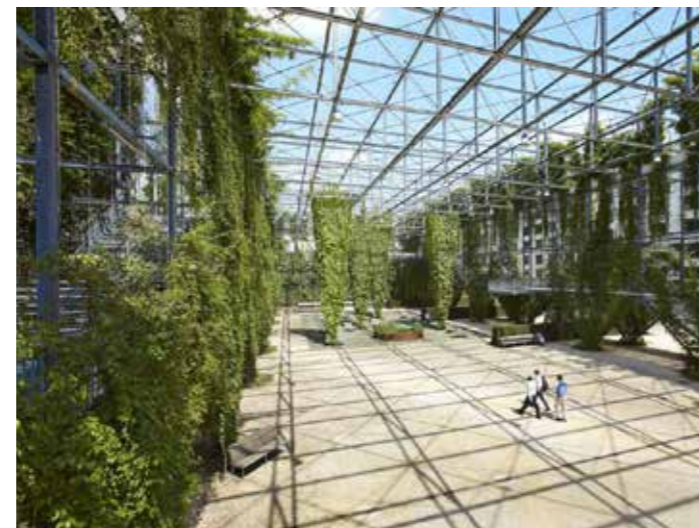
Abb. 1: MFO Park Zürich, der Kletterpflanzenpark dient als raumbildendes Element mit Bauwerkscharakter im öffentlichen Raum (© Jakob AG)
