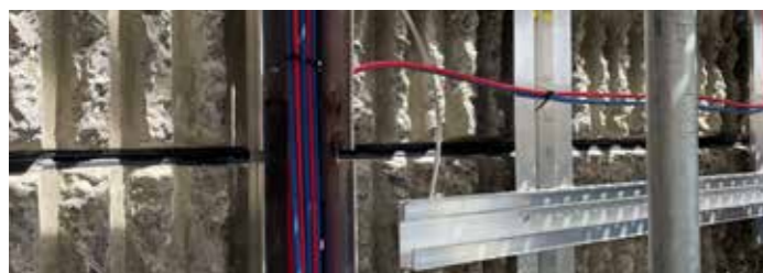
Abb. 64: Horizontale Elementfuge zwischen den vorgehängten Betonelementen der Fassade (© Silvia Domingo Irigoyen)
