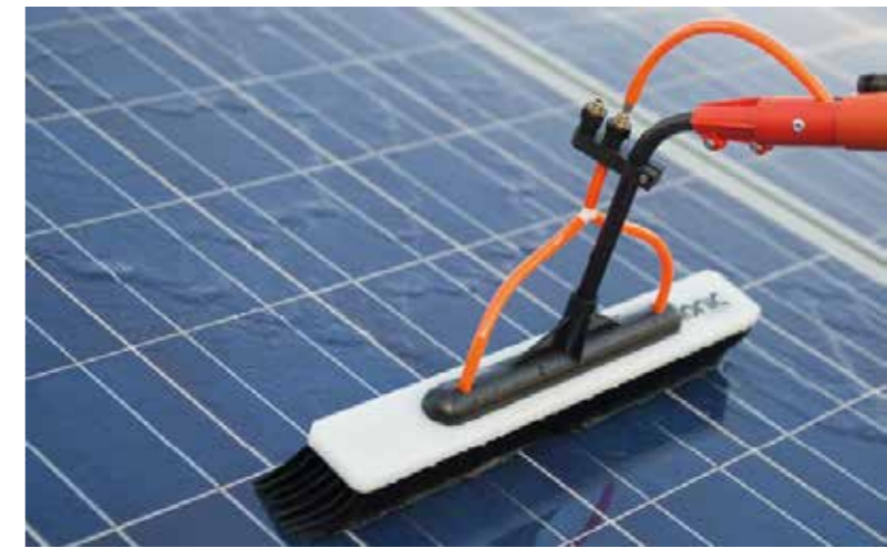
Abb. 51: PV-Module sind i.d.R. wartungsarm, eine regelmässige Reinigung der Anlage ist jedoch wichtig, um ein ansprechendes Erscheinungsbild und eine hohe Effizienz zu erreichen (© ADU Service Gruppe)
