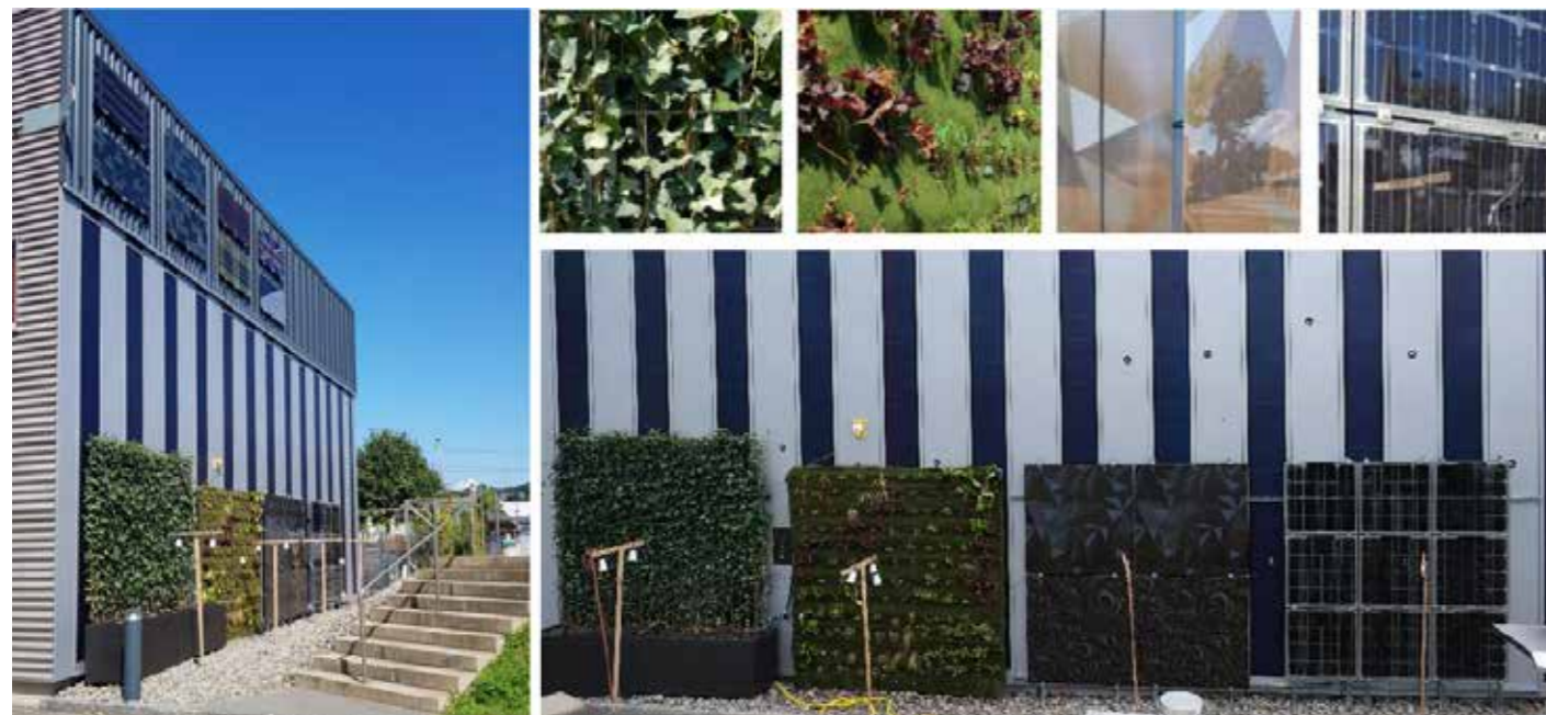
Abb. 96: Fassadenprüfstand auf dem Campus der HSLU in Horw
