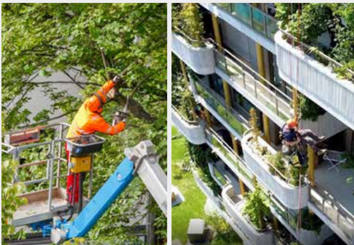
Abb. 14: Begrünungen benötigen eine regelmässige Pflege (links, © AdobeStock) (rechts, © newhome, Jürg Zulliger)
