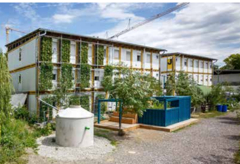
Abb. 25: Rosensteinviertel in Stuttgart, Versorgung der Fassadenbegrünung mittels gespeichertem Regenwasser und aufbereitetem Grauwasser (© J. Rettig).
