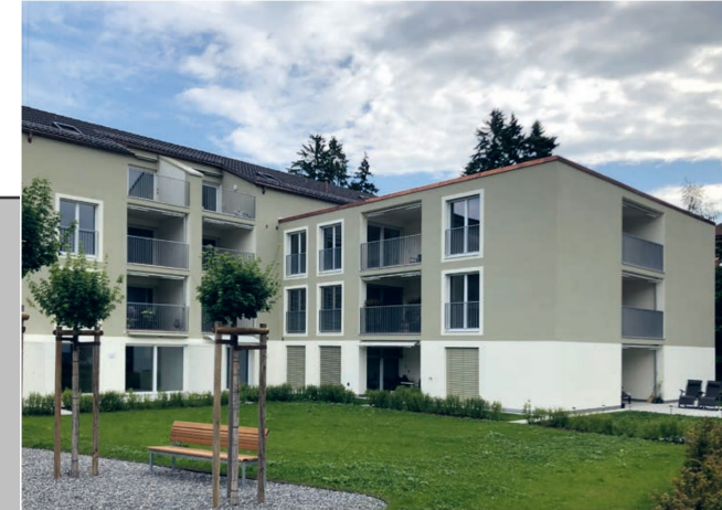
Das Minergie-Monitoring beim neuen Mehrfamilienhaus in Reinach (AG) zeigte, dass Fehleinstellungen aus der Inbetriebnahme optimiert werden mussten. (Foto: Jabez AG)
