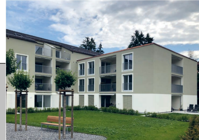
Das Minergie-Monitoring beim neuen Mehrfamilienhaus in Reinach (AG) zeigte, dass Fehleinstellungen aus der Inbetriebnahme optimiert werden mussten. (Foto: Jabez AG)
